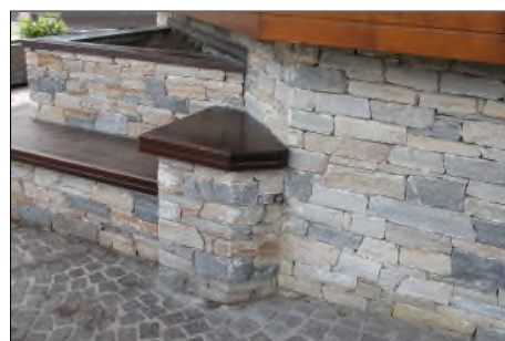
Mauer mit Steinen mit der Presse geschnitten
